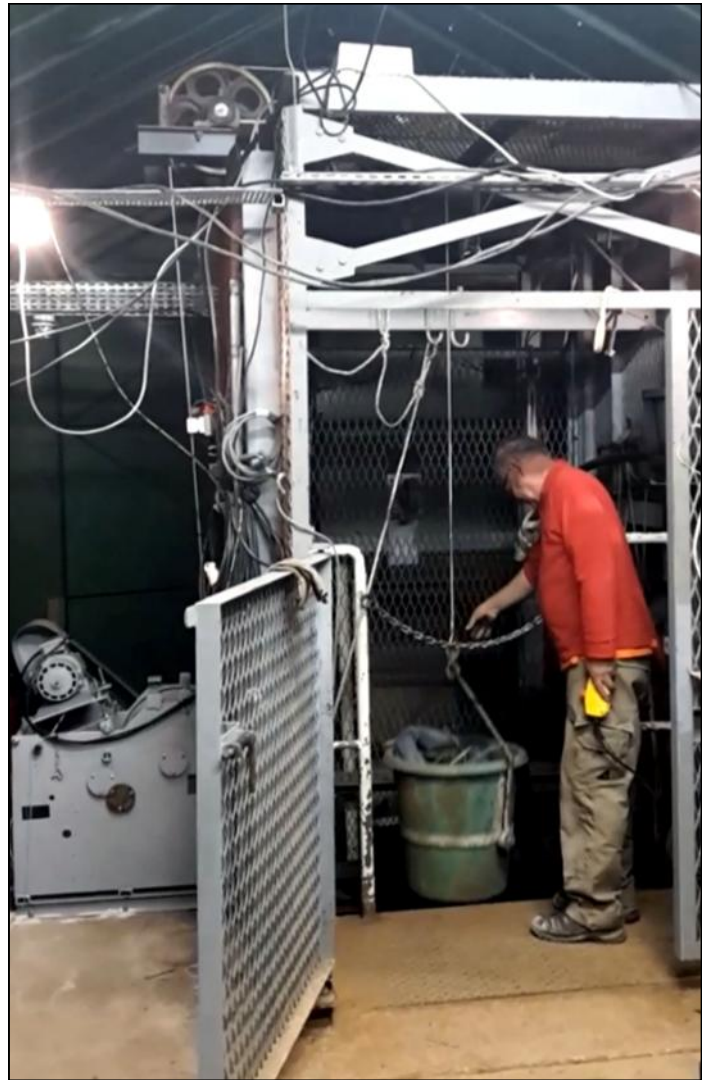
Francis Schira, alias Chouca, dans ses œuvres. Remplacement du vieux treuil, d'un poids de 400 kg. Les commandes de manœuvre ont été refaites et un nouveau générateur donne toute la puissance nécessaire.
