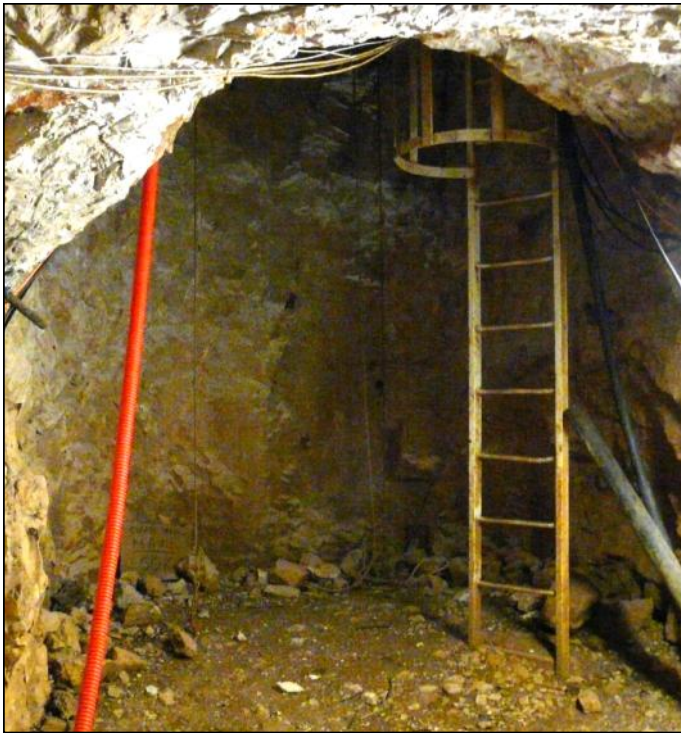
L'arrivée du puits dans la galerie avec l'escalier latéral, toujours emprunté par les plongeurs et leur assistance.
