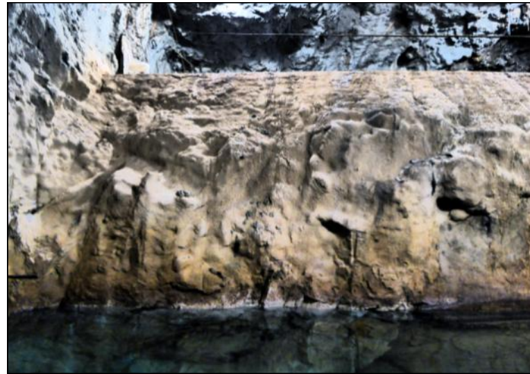
La taille brute du rocher formant le déversoir apparaît sur cette photo, malgré un léger crépi au mortier.
