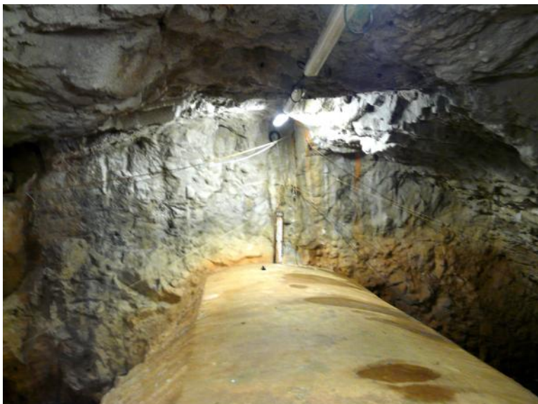
La crête du déversoir, cimentée et lissée, est large de 3 m. Au fond : le limnimètre qui aurait servi à mesurer le débit des crues, s'il n'y avait pas des fuites sous le barrage.
