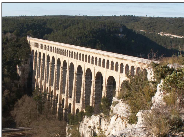
Fig. 1 : La merveille locale, l'aqueduc qui enjambe la vallée de l'Arc. On voit en arrière plan le plateau presque horizontal taillé par la rivière.
