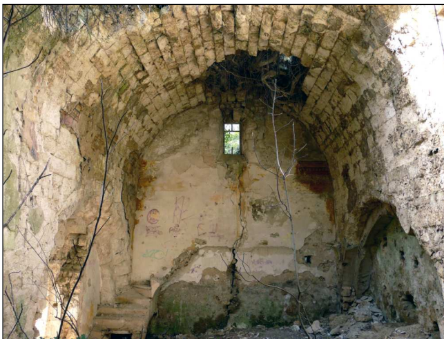
Fig. 7 et 8 : En haut, la voûte plein-cintre qui ne tardera pas à s'effondrer. En bas, au dessus de la porte d'entrée, l'ogive qui préfigure l'arrivée du gothique.
