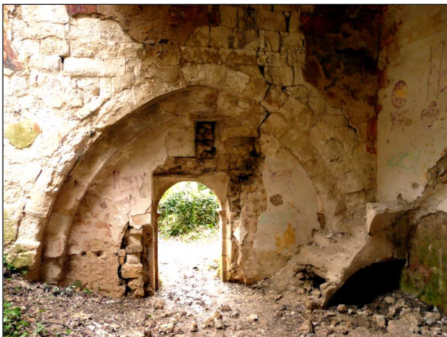
Fig. 7 et 8 : En haut, la voûte plein-cintre qui ne tardera pas à s'effondrer. En bas, au dessus de la porte d'entrée, l'ogive qui préfigure l'arrivée du gothique.
